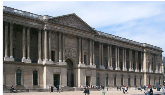
Le Louvre – « colonnade de Perrault »
